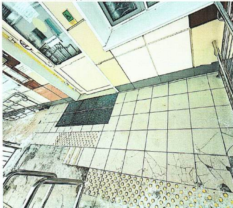
ФОТО № 24 Входная площадка
