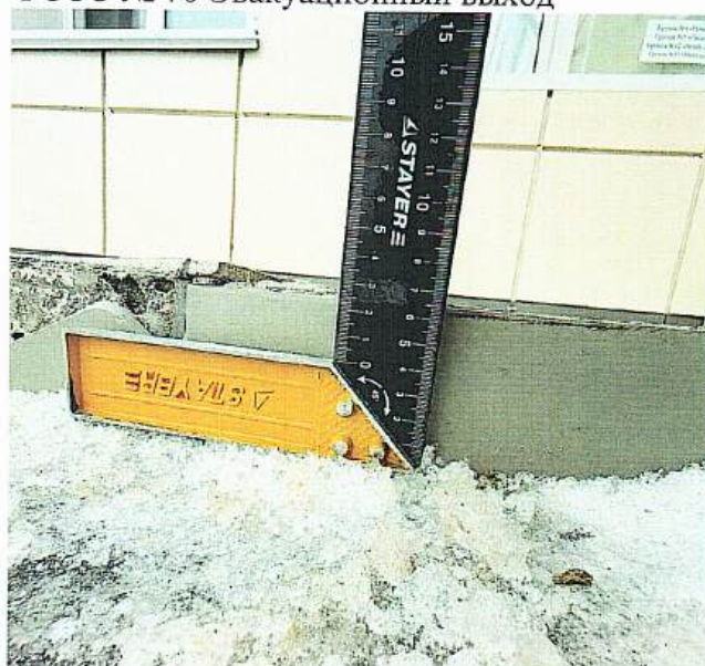
ФОТО № 70 Эвакуационный выход
