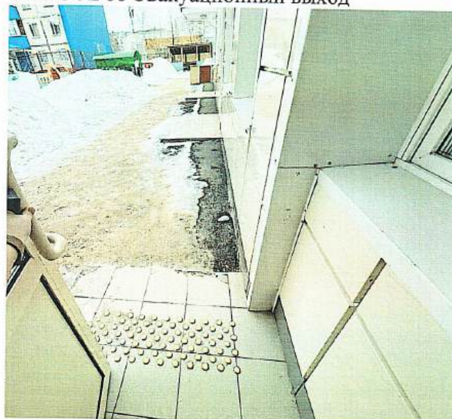
ФОТО № 68 Эвакуационный выход
