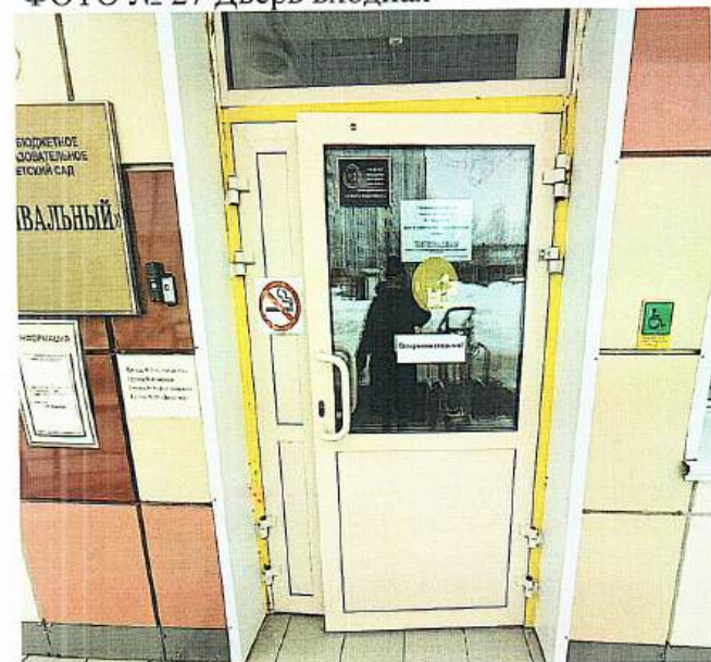
ФОТО № 27 Дверь входная
