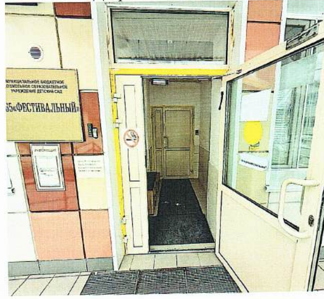
ФОТО № 28 Дверь входная
