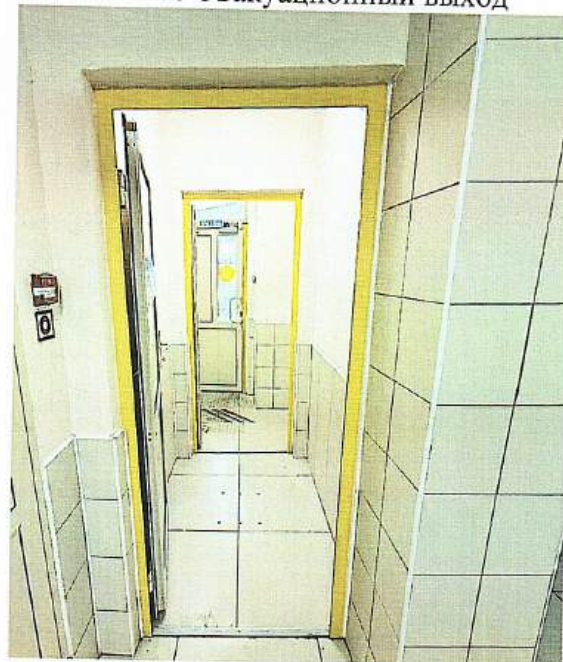
ФОТО № 66 Эвакуационный выход
