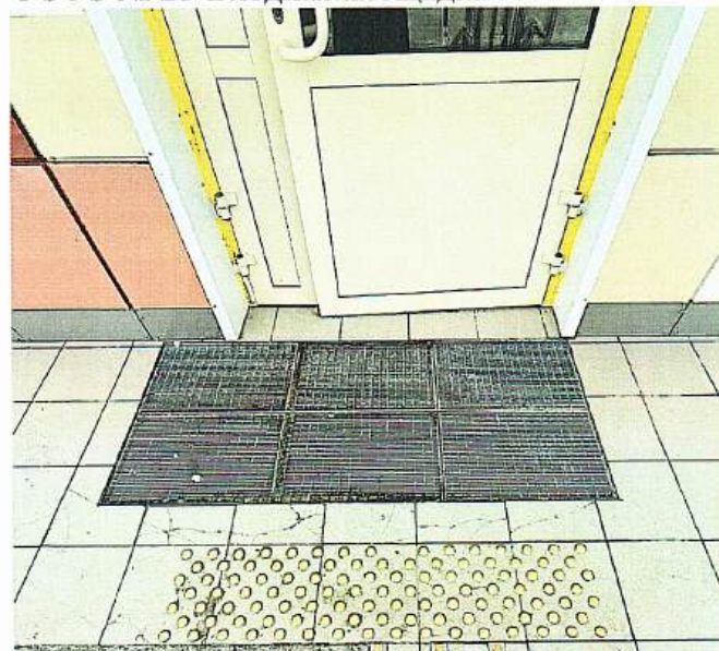
ФОТО № 26 Входная площадка
